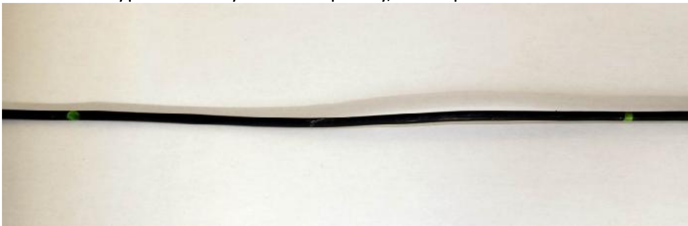
Kabel v oblasti kotvy po demontáži – výsledek kabel neporušený, izolace neporušená!
